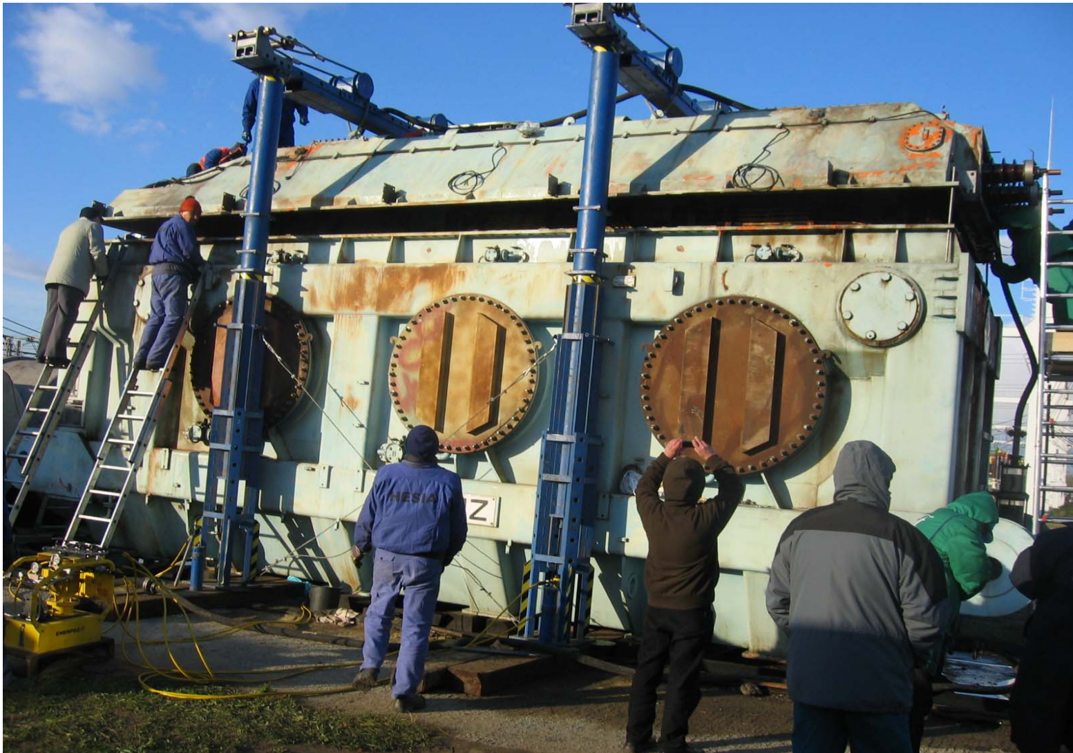
Fedél emelése aktív rész és OLTC nélkül
