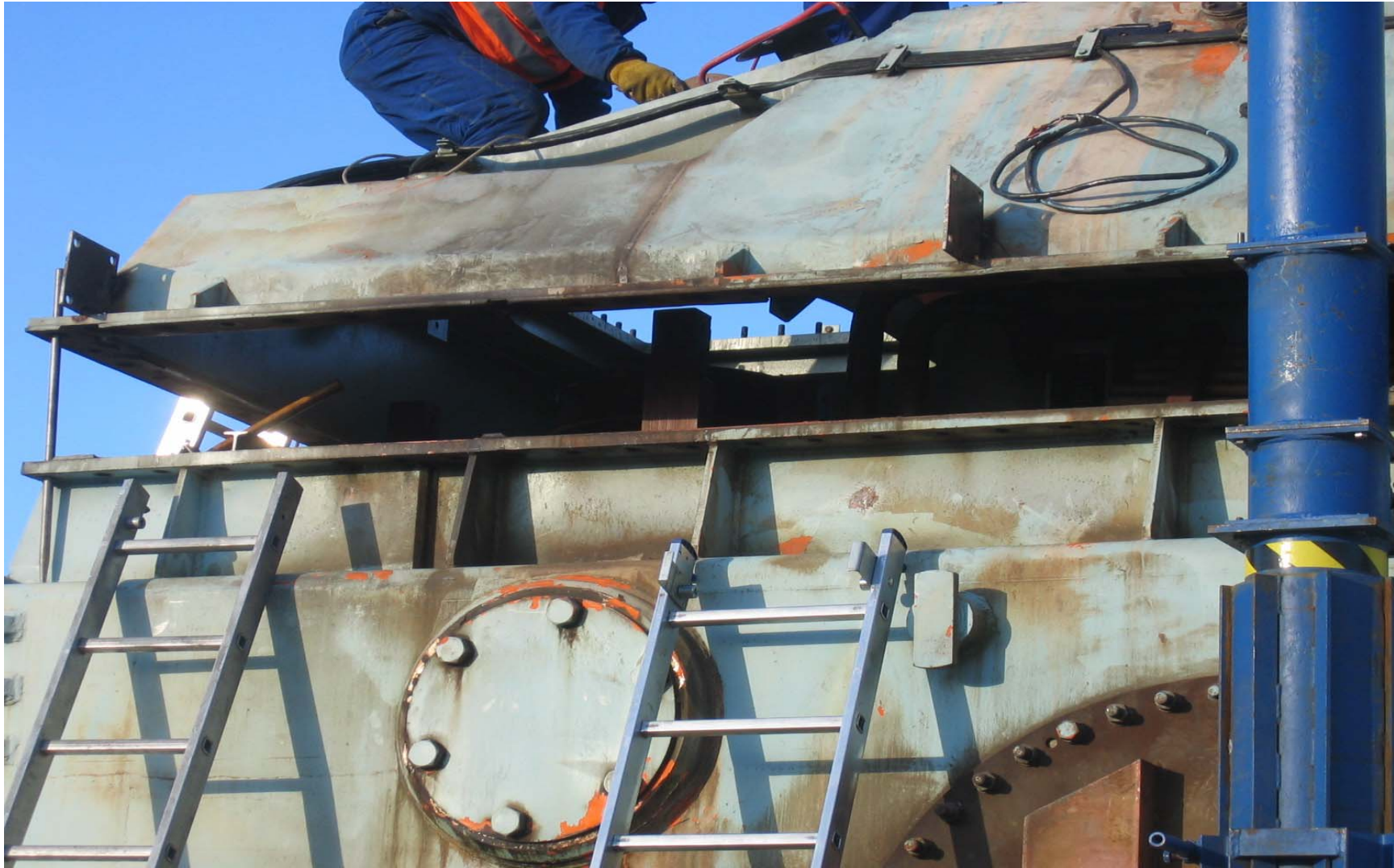
Fedél emelése aktív rész és OLTC nélkül
