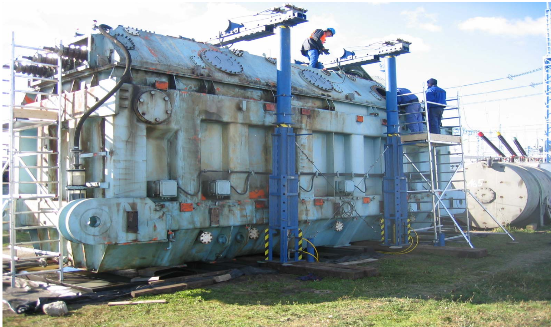
Fedél emelés, trafó nyitás a CRAB emelő rendszerrel (CRAB összeszerelés)
